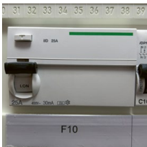
Fehlerstrom-Schutzeinrichtungen (RCD) schützen vor elektrischem Schlag und Bränden. Man erkennt sie an der Test-Taste.
